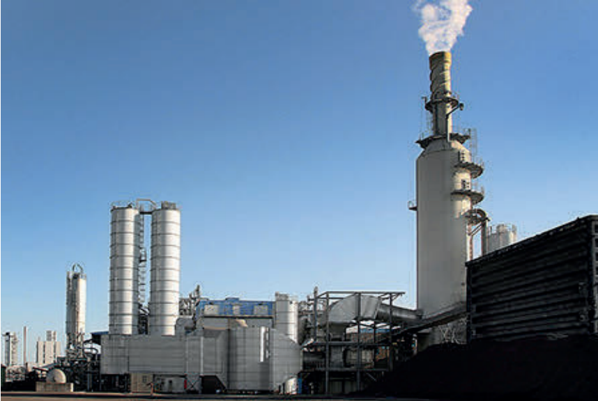
Vergleichbare Rauchgasreinigungsanlage mit DeNOx-Stufe und DeSOx-Wäscher in Betonbauweise
